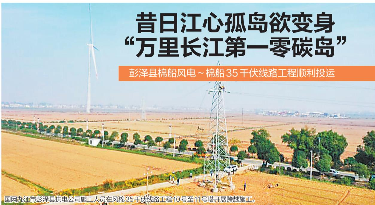
国网九江市彭泽县供电公司施工人员在风棉35千伏线路工程10号至11号塔开展跨越施工。
